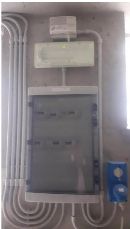
**Foto 4: Quadro elettrico da mantenere e verificare nei collegamenti**
