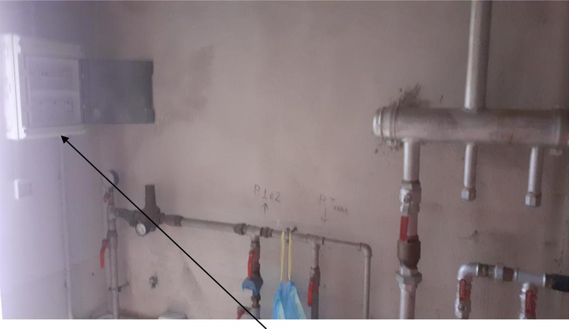
**Foto 7: Quadro da sostituire**
