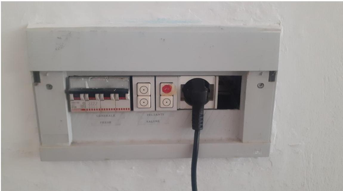
**Foto 12 Quadro elettrico gestioni luci e prese da sostituire**
