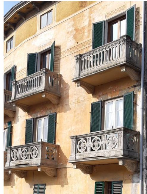
Figure 31-32 – Esempi di balconi in cls nel centro storico di Burolo.
