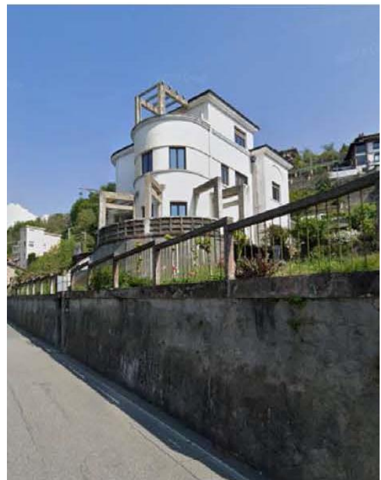
Figura 13-Edificio razionalista su Via Nuova
